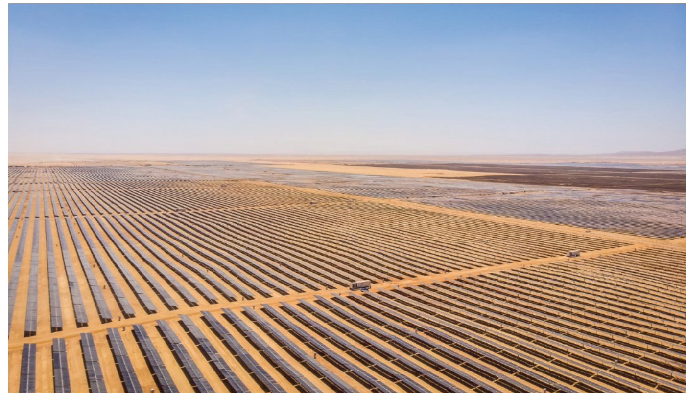
Solceller så langt øyet kan se: Bildet viser en del av norske Scatec Solar sitt solcelleanlegg på 400 MWp i Benban i Egypt. Anlegget er en del av et megaprojekt på 37,2 km 2 (!) i den egyptiske ørkenen, og skal produsere ca. 3,8 TWh energi i året. Egypt har som mål å være 42 % drevet av fornybar energi innen 2025. Foto: Scatecsolar.com
